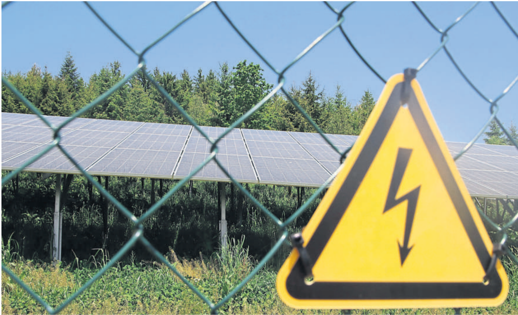
Ein gelbes Schild an einer Photovoltaik-Anlage warnt vor elektrischem Strom.
