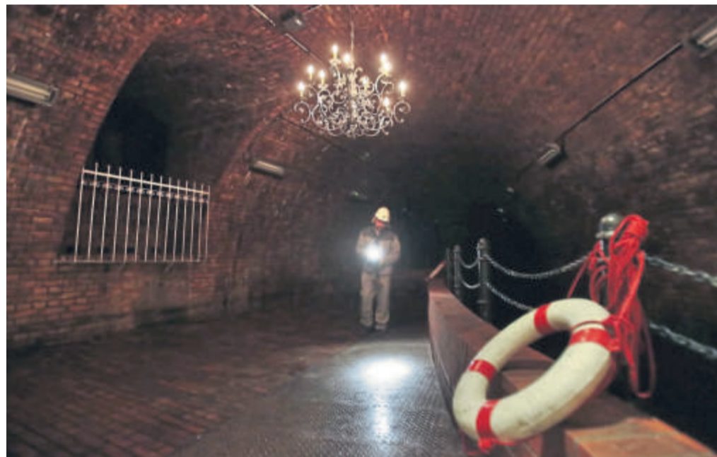
Kronleuchtersaal in der Kölner Kanalisation: Zur Einweihung 1890 wurde der Raum mit zwei Kronleuchtern ausgestattet, weil Kaiser Wilhelm II. eingeladen war. Eine Nachbildung hängt noch heute dort.
