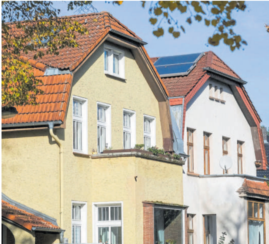
Die Grundsteuerreform betrifft Millionen Hessen: direkt die Eigentümer, indirekt auch die Mieter.
