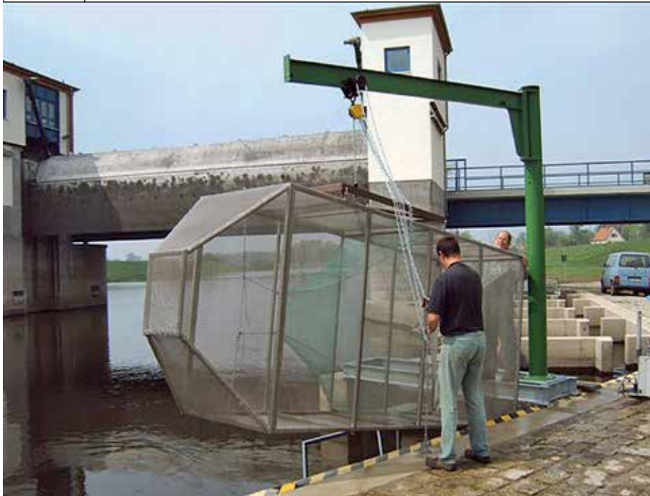
Abb. 2: Spezialreuse für das Steigaalmonitoring am Wehr Gnevsvord
