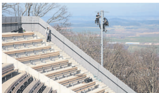
Bühnentechnik wird von Handwerkern im Harzer Bergtheater in Thale installiert.
