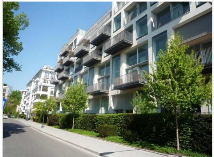
Außenansicht / Exterior View
