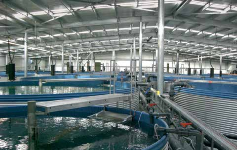
Kreislaufsystem zur Erzeugung von jährlich 300 Tonnen Flussbarschen.
