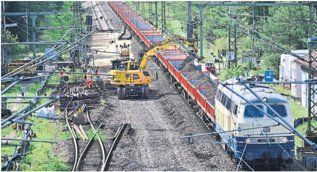
**Gesperrt bis Ende April 2026:** Während der Generalsanierung der Bahnstrecke Hamburg-Berlin gräbt ein Bagger Schotter von der Strecke.
