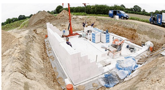
Bei Einfamilienhäusern war das Plus bei den Baugenehmigungen im bisherigen Jahresverlauf besonders hoch. M. SCHOLZ/DPA
