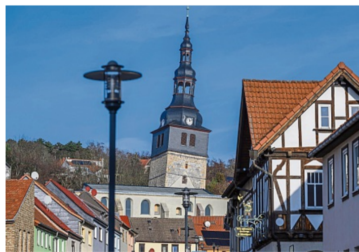
Mit einem Überhang von inzwischen 4,86 Metern ragt der Turm der Oberkirche über die Hausdächer von Bad Frankenhausen.
