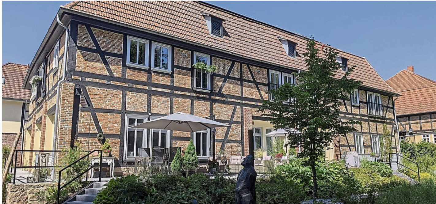
Die sanierte Grafenscheune, zuletzt wurde die Scheune teils als Lagerraum und Stellplatz genutzt.
