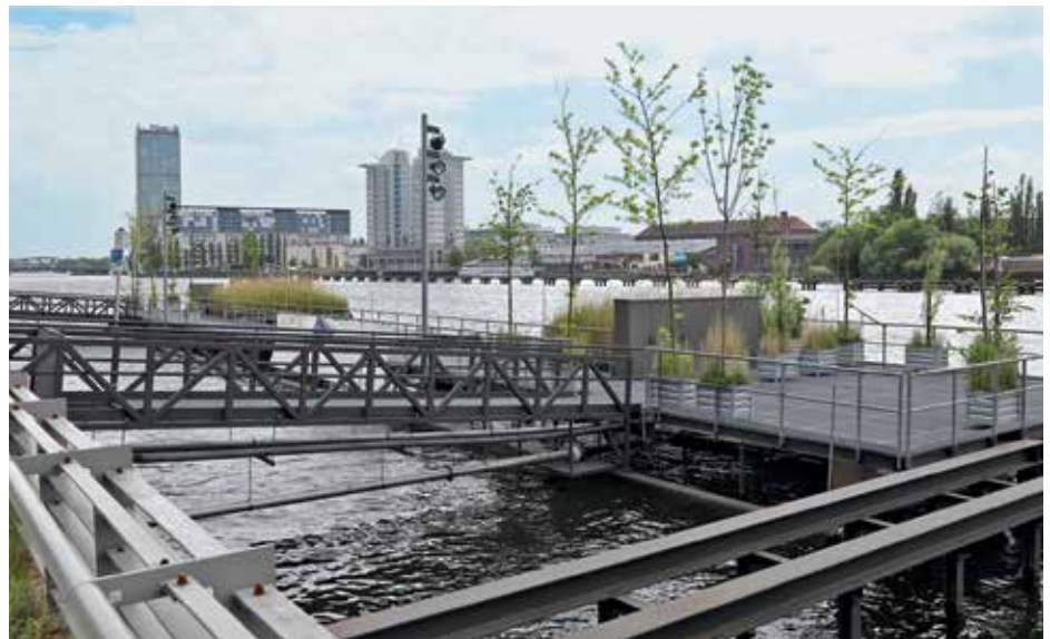
Das LURITEC-Baukastensystem ermöglicht die Errichtung von modularen Rückhaltebecken
