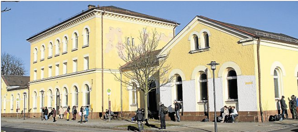
Der Bahnhof in Wiesau verfällt. Wie bereits berichtet, kauft der Markt Wiesau nun das Gebäude. Eine Machbarkeitsstudie des Architekturbüros Brückner errechnete für eine Revitalisierung Kosten rund 2,5 Millionen. Bild: wg
