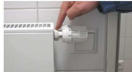
Die gelockerte Überwurfmutter lässt sich dann mit der Hand abschrauben.
