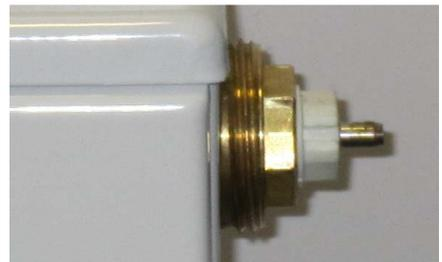
Versuchen Sie bitte nun mit einem harten Gegenstand, z.B. mit der flachen Seite der Rohrzange, diesen Ventilstift hineinzudrücken. Mit leichtem bis mittlerem Kraftaufwand sollte dies funktionieren. Bewegen Sie diesen Stift dann mehrmals nach innen und lassen ihn wieder heraus (ca. 5 x sollte reichen).
