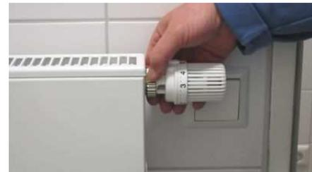
Wenn die Überwurfmutter vollständig abgedreht ist, nehmen Sie den Thermostatkopf ab und legen ihn beiseite.
