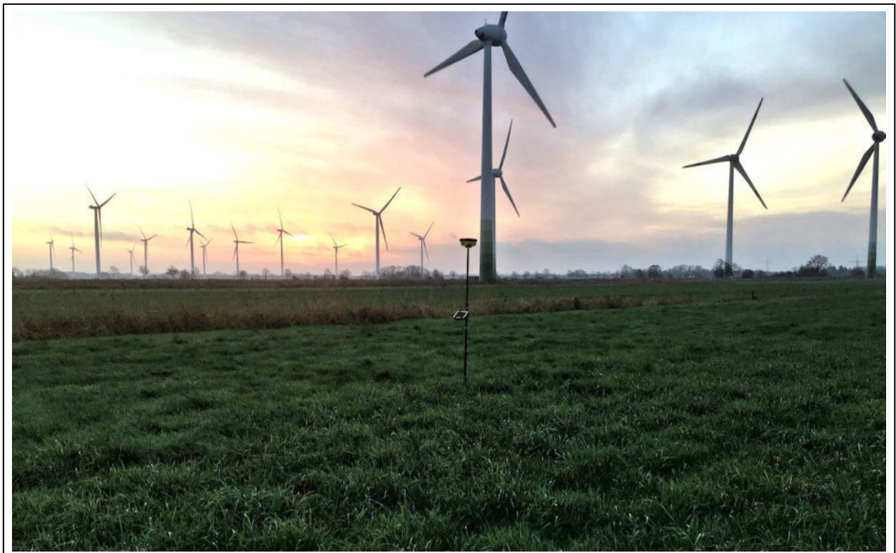
Abbildung 5.3: Blick in Richtung des geplanten Anlagenstandortes WEA 3 neu
