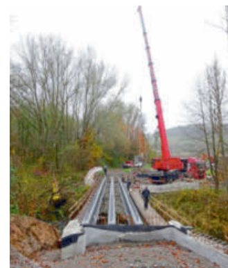
Der Neubau der Nethebrücke ist abgeschlossen. Um die massiven Stahlteile der neuen Brücke in die richtige Position zu bringen, war schweres Gerät notwendig. Foto: Kreis Höxter
