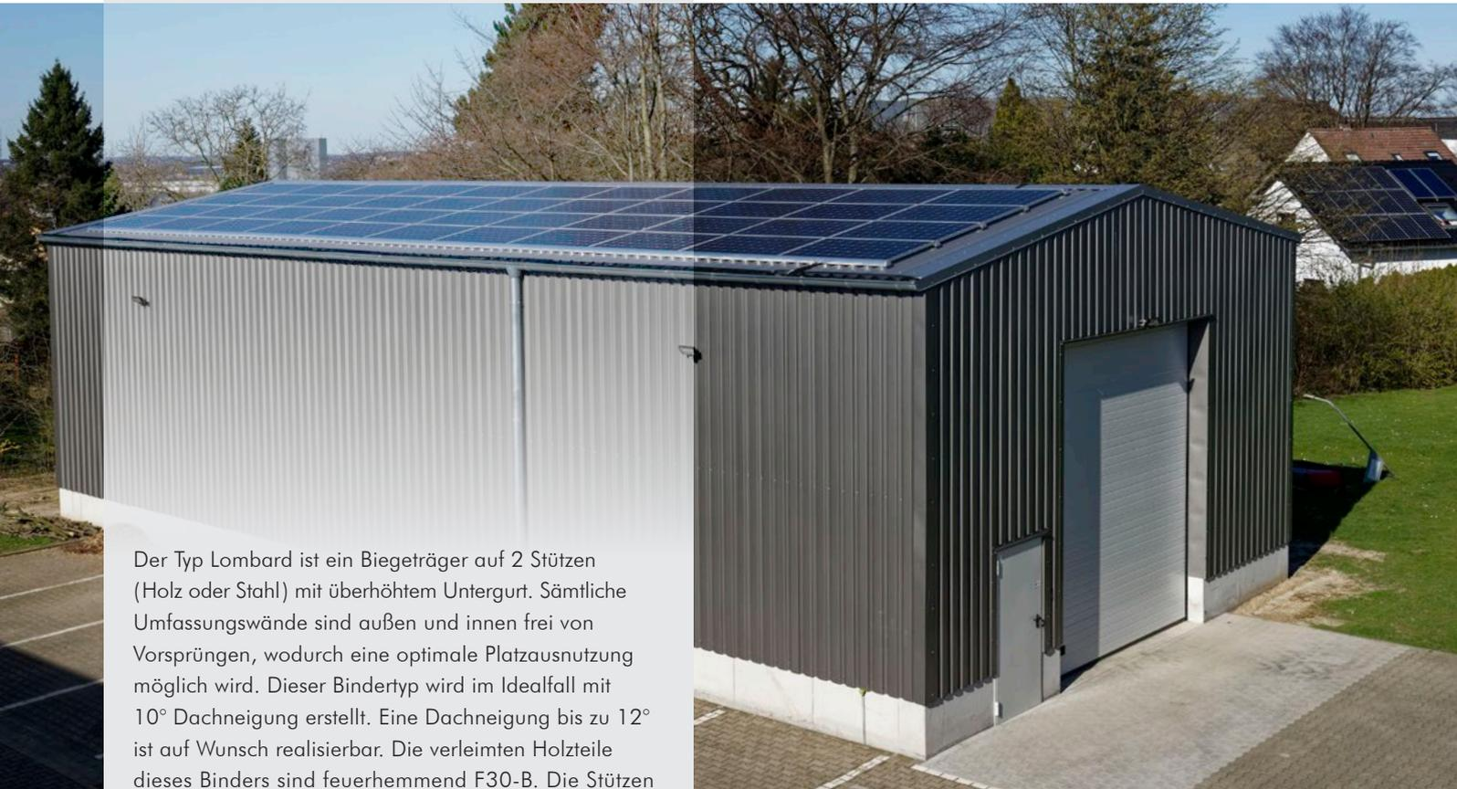
Der Typ Lombard ist ein Biegeträger auf 2 Stützen (Holz oder Stahl) mit überhöhtem Untergurt. Sämtliche Umfassungswände sind außen und innen frei von Vorsprüngen, wodurch eine optimale Platzausnutzung möglich wird. Dieser Bindertyp wird im Idealfall mit 10° Dachneigung erstellt. Eine Dachneigung bis zu 12° ist auf Wunsch realisierbar. Die verleimten Holzteile dieses Binders sind feuerhemmend F30-B. Die Stützen können sowohl einseitig als auch beidseitig eingespannt werden.
