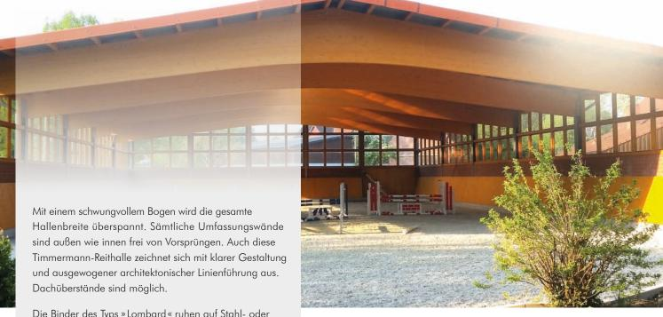
Die Binder des Typs »Lombard « ruhen auf Stahl- oder Holzstützen.
