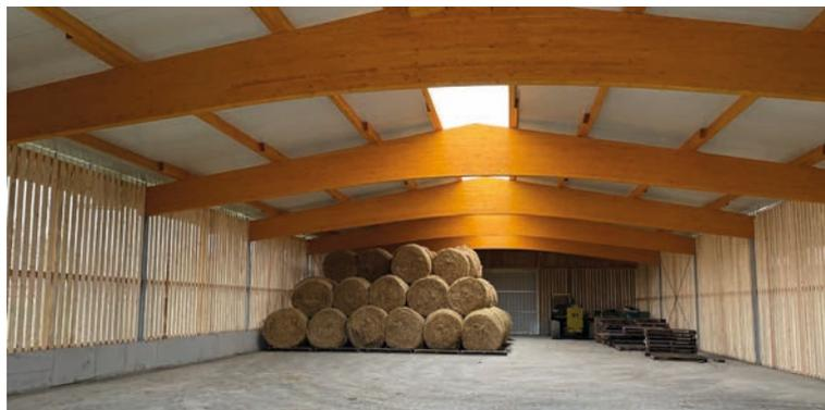
Dieser Typ findet seine Hauptanwendung im Produktionshallenbereich und bietet eine saubere Lösung einer Hallenkonstruktion. Mögliche Dacheindeckungen: asbestfreie Faserzementplatten, Sandwichelemente oder Trapezbleche mit Vlies. Alle Dacheindeckungen sind in diversen Farben möglich.
