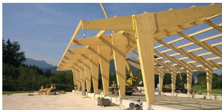
Die klare Gestaltung und ausgewogene architektonische Linienführung kennzeichnen diese Hallenkonstruktion. Mögliche Dacheindeckungen: asbestfreie Faserzementplatten, Sandwichelemente oder Trapezbleche mit Vlies. Alle Dacheindeckungen sind in diversen Farben möglich. Eine feuerhemmende Ausführung in F30-B nach DIN 41 02 ist mit geringem Aufwand realisierbar.
