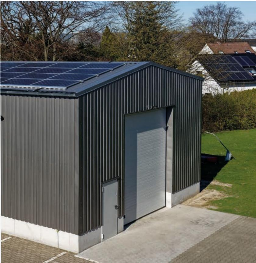
Der Typ Lombard ist ein Satteldachträger auf 2 Stützen (Holz oder Stahl) mit überhöhtem Untergurt. Sämtliche Umfassungswände sind außen und innen frei von Vorsprüngen, wodurch eine optimale Platzausnutzung möglich wird. Dieser Bindertyp wird im Idealfall mit 10° Dachneigung erstellt. Eine höhere Dachneigung ist auf Wunsch realisierbar. Dieser Binder ist feuerhemmend F30-B. Die Stützen können sowohl einseitig als auch beidseitig eingespannt werden. Dachüberstände sind möglich.
