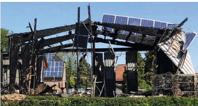
Diese beispielhaften tragenden Holzbauteile zeigen eindeutig die Holzkohleschicht, die den unverbrannten Holzkern vor weiterer Zerstörung schützt und somit die Rettung von Menschenleben und die Sicherstellung wichtiger, kostbarer Güter ermöglicht. Die tragende Konstruktion blieb nach einem Vollbrand stehen.
