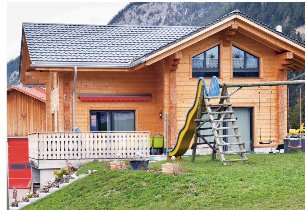
«Holz isch heimelig» und ein hervorragender Baustoff.
