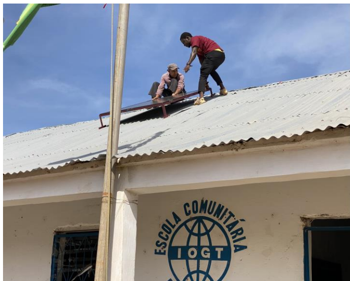
Dixon und Samba installieren das Solarpanel.
